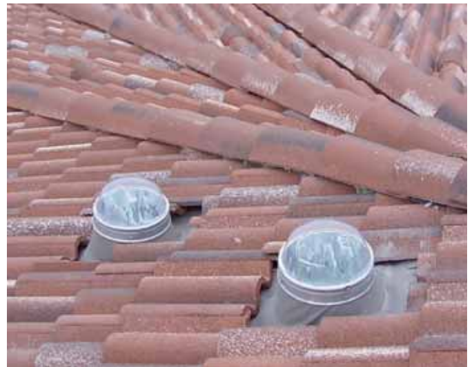
La scossalina universale - PROTEO™ - per qualsiasi tipo di tegola e tetto inclinato (installazione zenitale o complanare) Disponibile per tutti i diametri.
